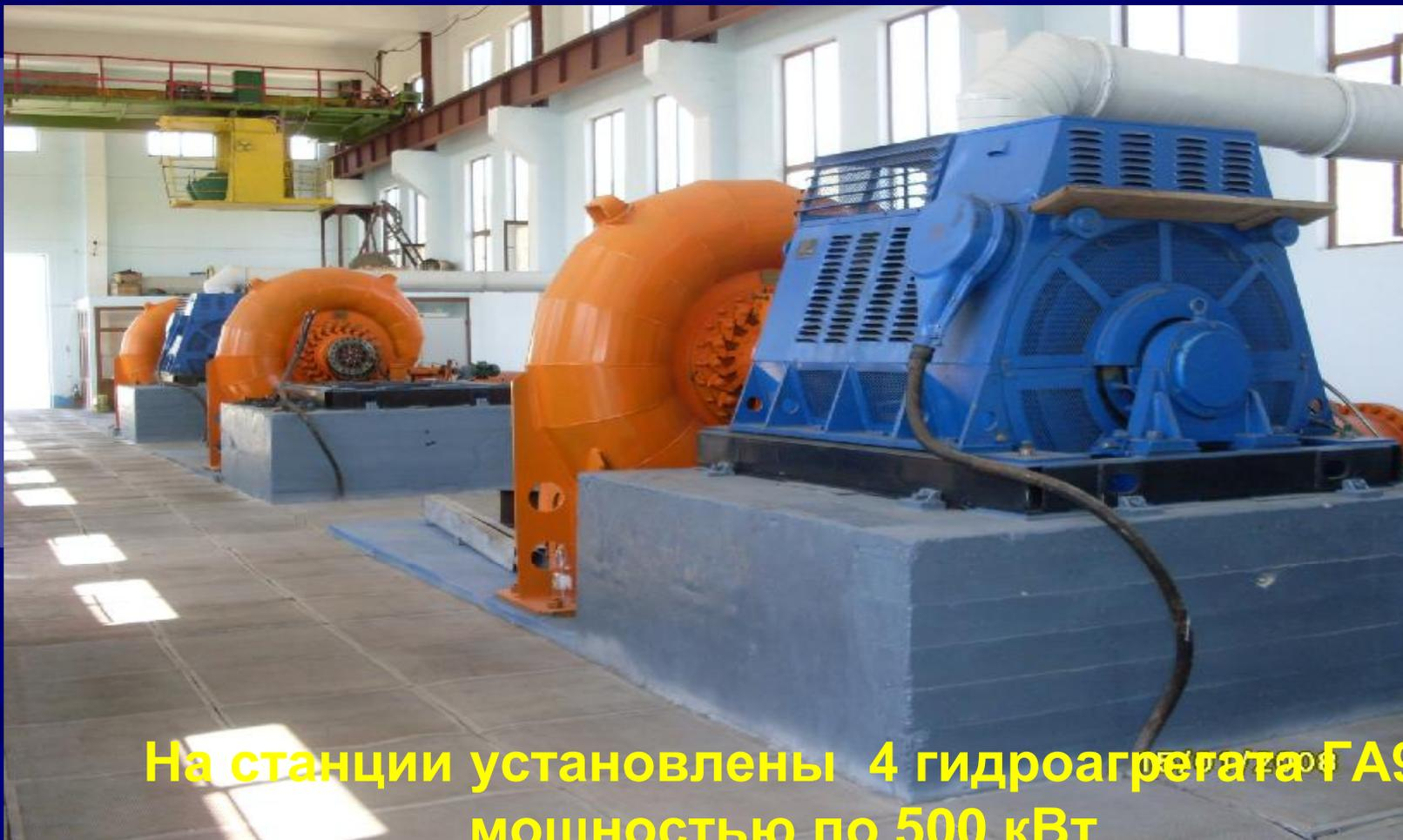
**На станции установлены 4 гидроагрегата ГА9
